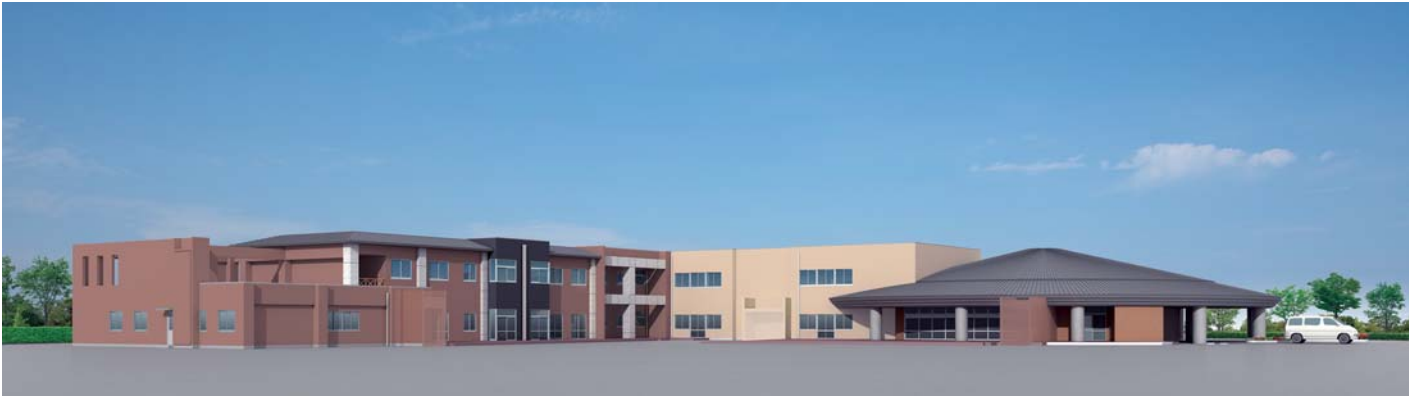
現在工事中の特別養護老人ホーム
